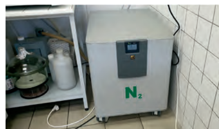
Obr. 3: Dusíkový generátor s integrovaným scroll kompresorem CASTORE XL IQ
